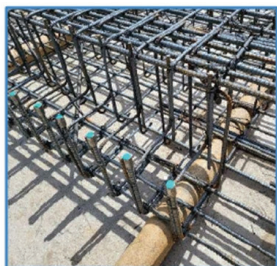
그림 15. 내진보강용 정착철근(커플러) 설치
