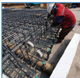
그림 16. 스티로폼 설치
