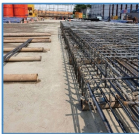
그림 14. 지하연속벽 철근망 조립
