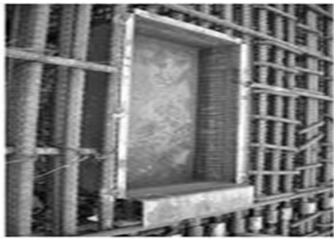
(d) Box-out Unit 설치
