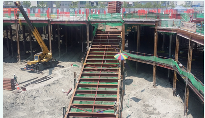
[사진 4] 직상차용 복공 램프 설치
