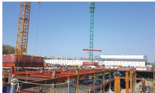
(b) 타워크레인을 이용한 철골보 설치 사진
