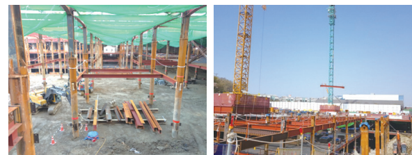
(a)백호를 이용하여 철골보를 설치하는 사진
